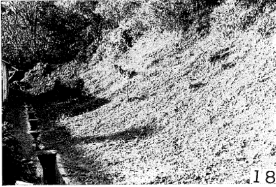
18. 生徒の力できれいにされた斜面
