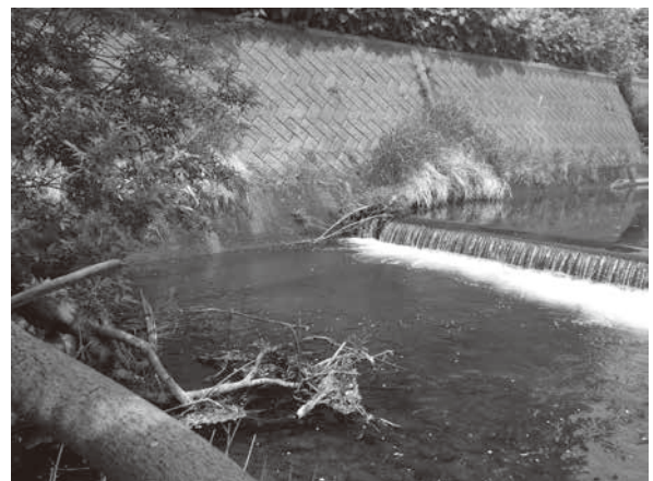
図8-2 魚道のない歓喜橋上流落差工
