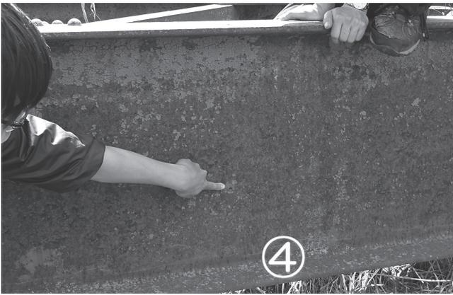
図9 桁A④の窪み
